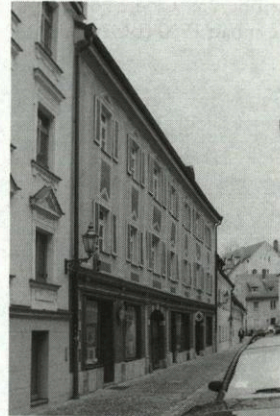
Abb. 22: Obere Bachgasse 23 von Norden.
