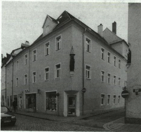
Abb. 97: Obermünsterstraße 10 von Nordwesten.
