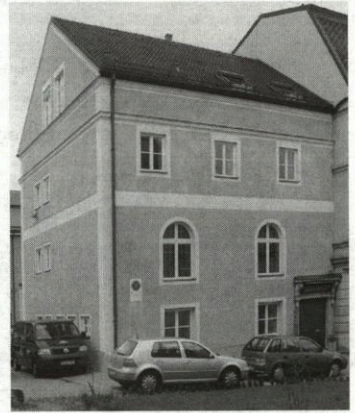
Abb. 74: Obermünsterplatz 10 (Süd) von Südosten.
