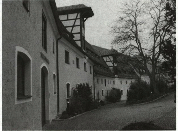
Abb. 16: An der Hülling 1, Hofseite.
