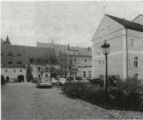
Abb. 73: Obermünsterplatz 10, das Brauereiareal nach dem Abbruch 1973/75.
