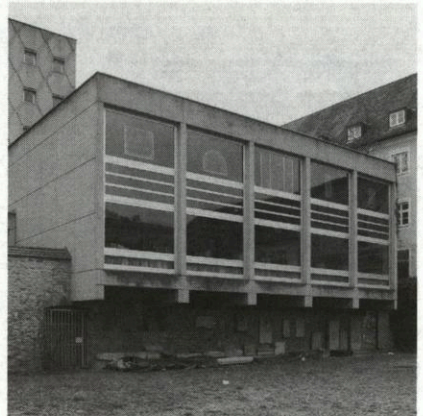
Abb. 123: St. Peters-Weg 13, Großer Lesesaal von Nordosten.
