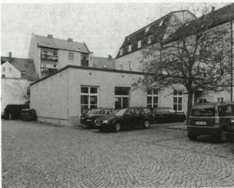
Abb. 75: Obermünsterplatz 10, Saalbau von 1910, nach Umbau 1974/75.
