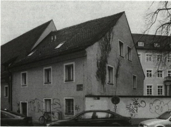
Abb. 102: St. Peters-Weg 7 von Süden.
