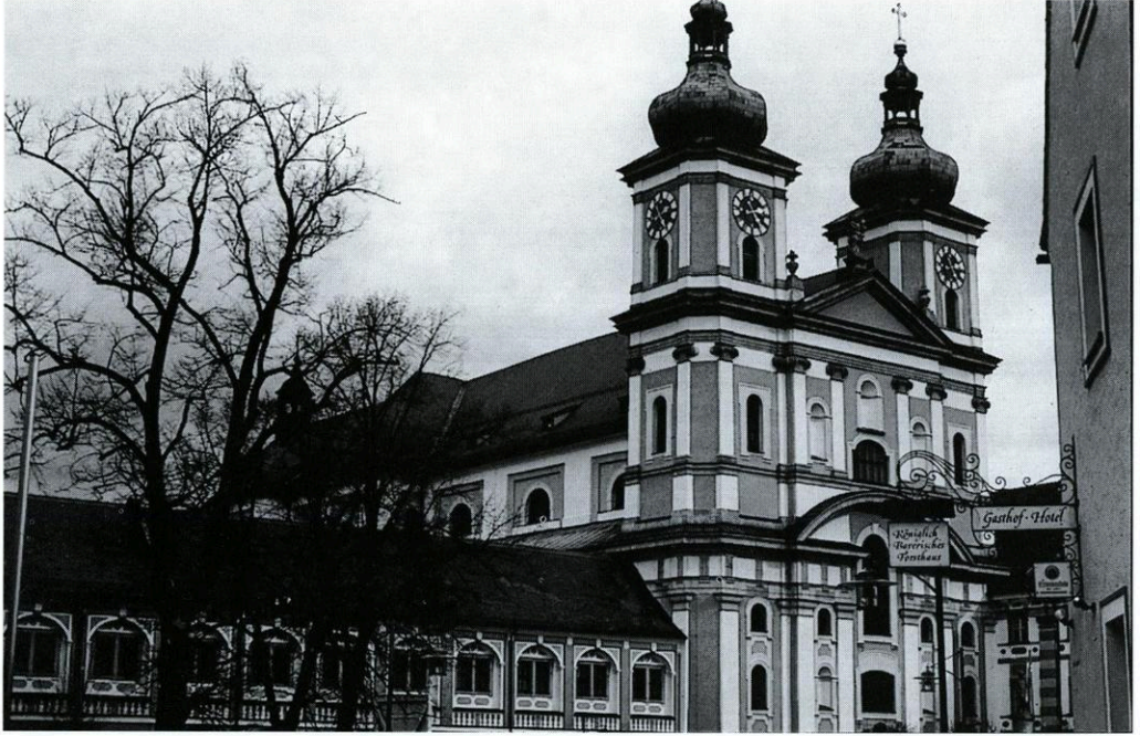
Abb. 1: Stiftskirche Waldsassen von Nordwesten. Die Dächer treten kaum in Erscheinung. Gerade noch erkennbar, ist das abgewalmte nördliche Querhausdach. Photo: Verfasser, März 2003.
