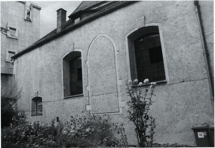
Abb. 6: St. Kassian, vermaueretes nachgotisches Fenster an der Südwand, Zustand 1999
