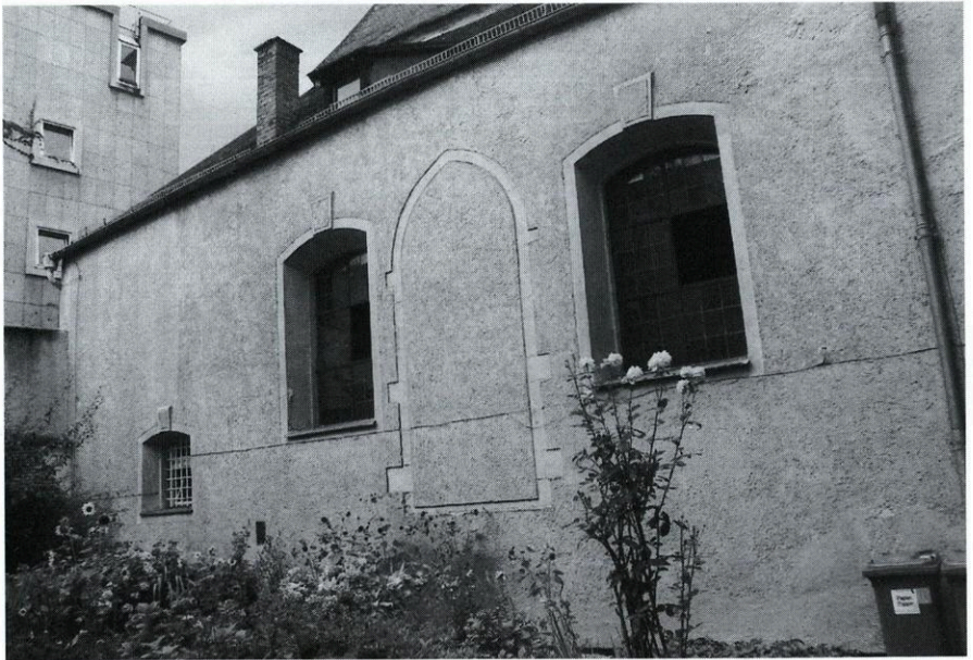
Abb. 6: St. Kassian, vermauerteres nachgotisches Fenster an der Südwand, Zustand 1999
