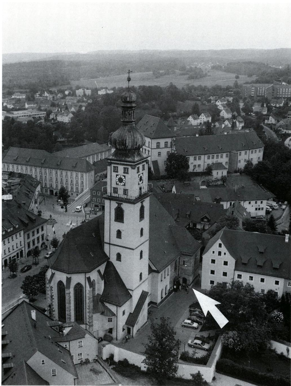
Abb. 4: Pfarrkirche St. Marien, ehem. Kirchenbibliothek (im Obergeschoß des Pfarrkirchen-Anbaus von 1529; Pfeil), rechts daneben ehem. „Lateinschule“ im Pfarrviertel (Zustand im Frühjahr 1998).
