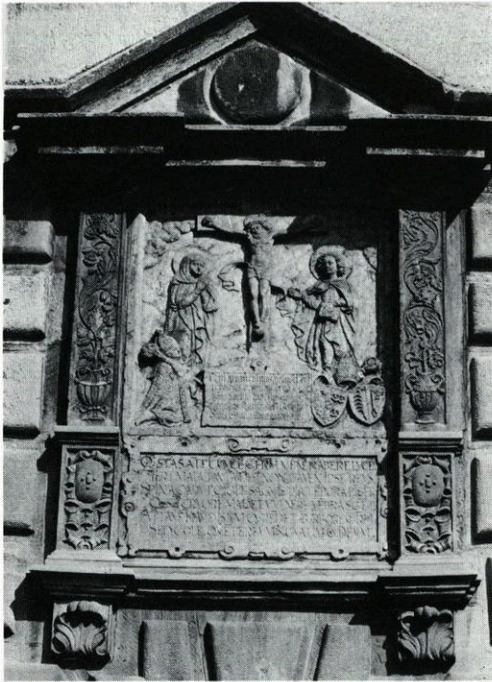
Abb. 15: Stifterrelief über dem Eingang an der Westseite des Glockenturmes
