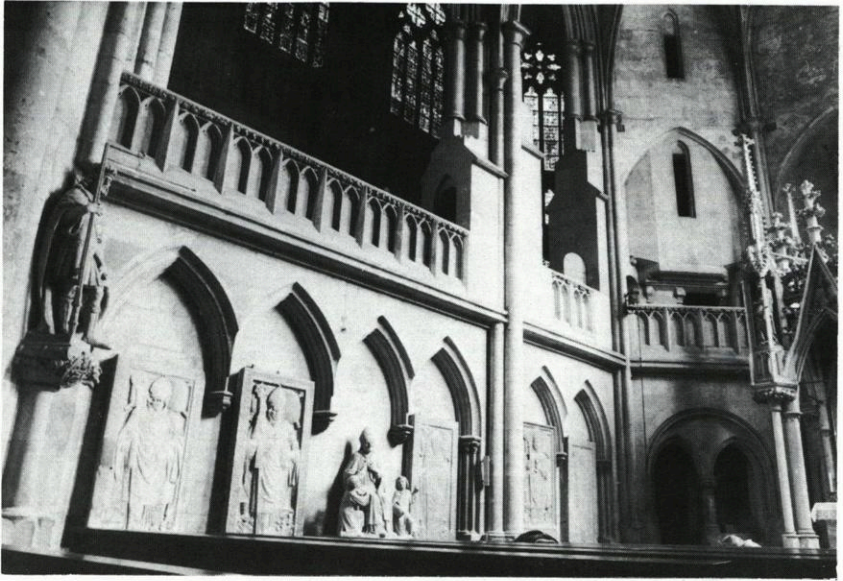
Abb. 7: Südchor Blendarkaden an der Trennwand zum Hauptchor und am Polygon
