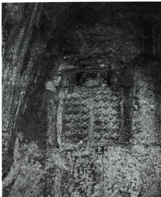
Abb. 14 a: Quadermauer im Nordflügel des östlichen Domkreuzgangs (Foto: C. Unger).
