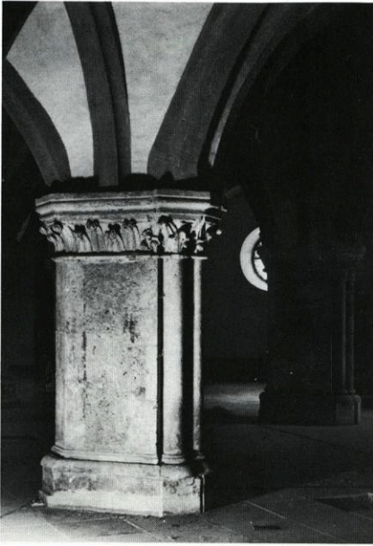
Abb. 10: Regensburg St. Ulrich, Pfeiler C 2 von Nordwesten mit der an der senkrechten Tüchlgrenze erkennbaren Abbruchspur der Quermauer. 1983
