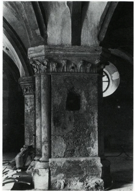
Abb. 11: Regensburg St. Ulrich, Pfeiler C 2 von Süden mit dem Rest der abgebrochenen Quermauer im Sockelbereich und Abbruchspur an der Pfeilerflanke darüber. Der offene Ausbruch ist, davon unabhängig, für ein Weihwasserbecken geschlagen worden. 1982
