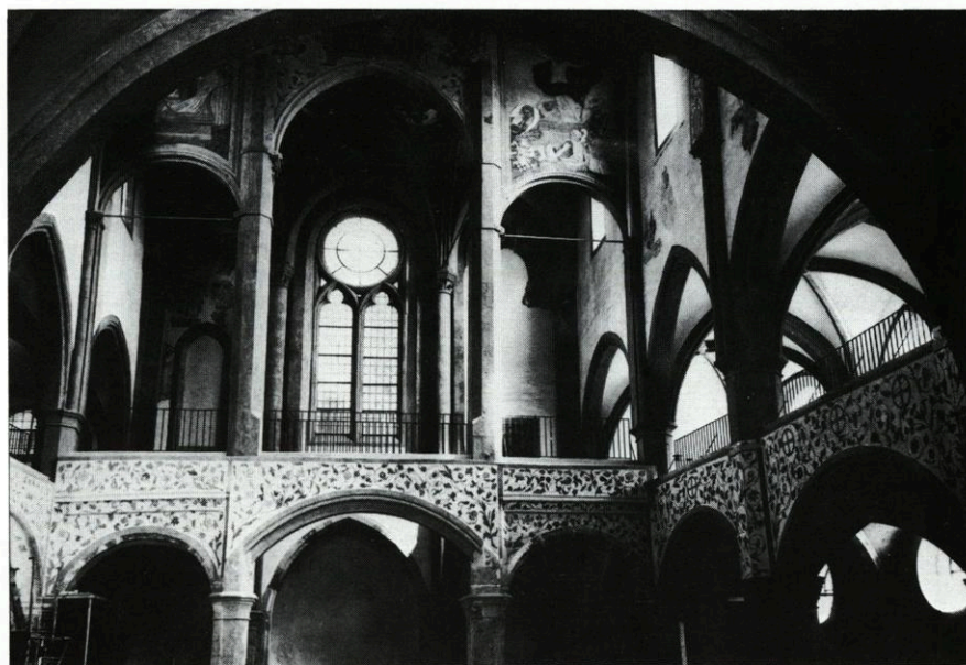
Abb. 2: Regensburg St. Ulrich, Innenraum nach der Instandsetzung
