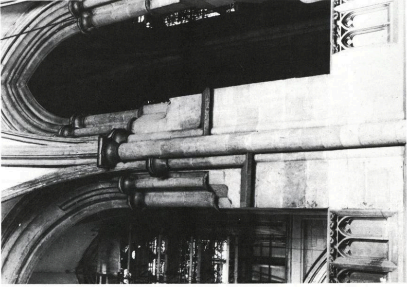
Abb. 2: Dienstbündel zwischen Polygon und Vordorjoch an der Trennwand Hauptchor — südlicher Nebendor; vom südl. Nebendor aus gesehen
