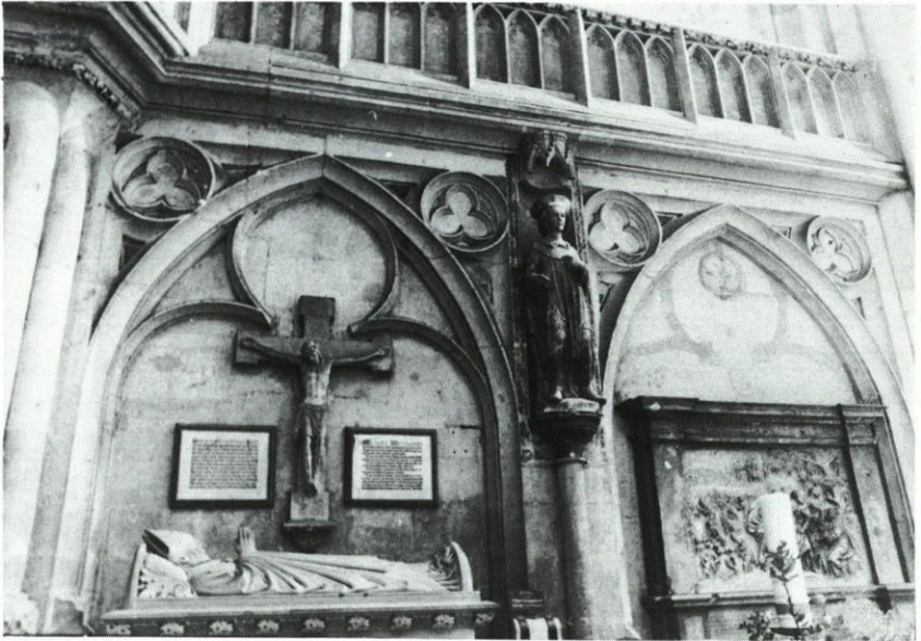
Abb. 8: Nordchor Vorchorjoch; Blendarkaden an der Trennwand zum Hauptchor
