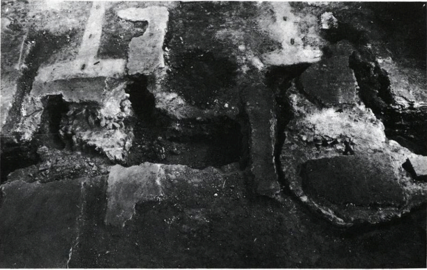
Abb. 8: Regensburg St. Ulrich, aufgedeckte Fundamente bei C 4 und D 4 von der Westempore gegen Osten gesehen. 1973
