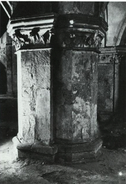
Abb. 12: Regensburg St. Ulrich, Winkelpfeiler B 2 von Nordwesten mit der an der Flickung der Kante und der Ergänzung im Sockel erkennbaren Spur der abgebrochenen Quermauer
