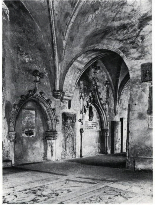
26. Domkreuzgang, Blick vom Mortuarium zum westlichen Südflügel. Romanischer Scheidbogen, spätgotische Wölbung und Arkosolnischen
