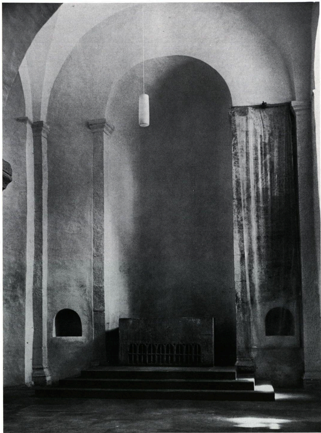
29. Stephanskapelle, Zustand 1964. Wiederherstellung der originalen Raumfassung, rechts der Apsis die noch nicht restaurierten Reste der Weiheinschrift
