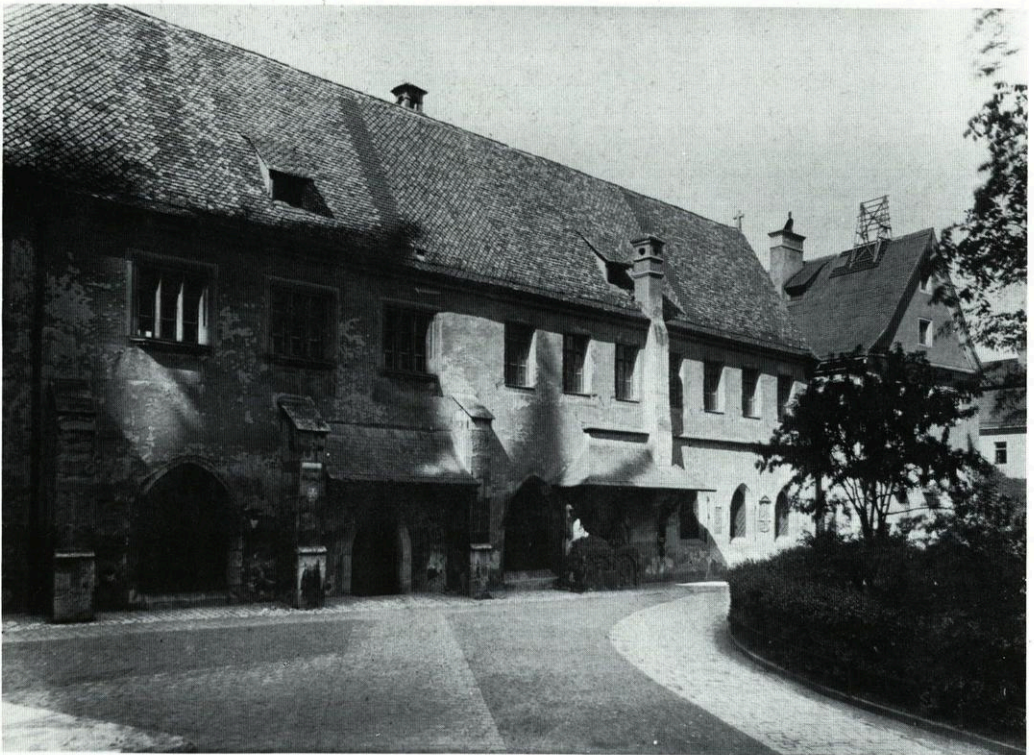
31. Domkapitelhaus Südseite, Zustand um 1930. Teile des Daches noch mit spätgotischen Sechseck-Bibern gedeckt
