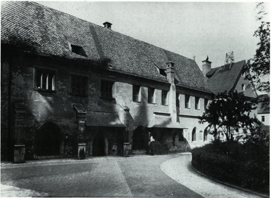
31. Domkapitelhaus Südseite, Zustand um 1930. Teile des Daches noch mit spätgotischen Sechseck-Bibern gedeckt
