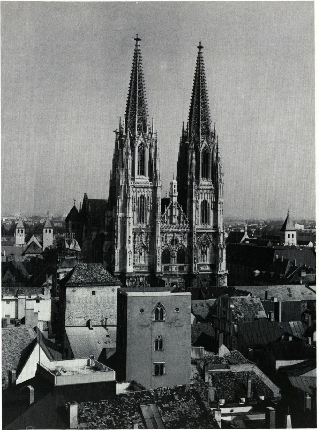
1. Ansicht des Regensburger Domes vom Rathausurm aus
