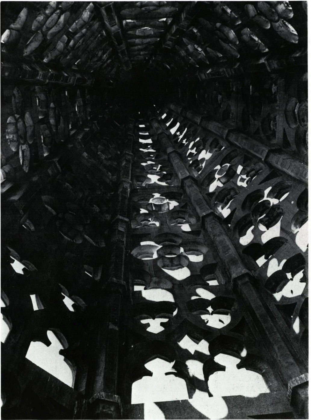
68. Blick in das Innere eines Turmhelms (heutiger Bestand).
