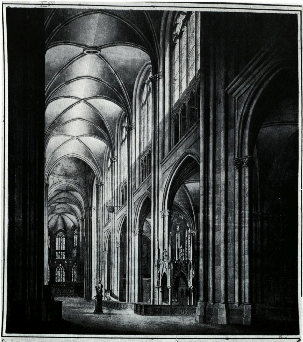
45. Innenansicht des Regensburger Domes. Gouache von Justus Popp. Regensburg, um 1830
