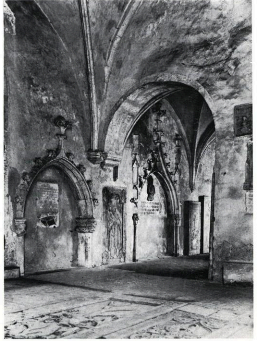
26. Domkreuzgang, Blick vom Mortuarium zum westlichen Südflügel. Romanischer Scheidbogen, spätgotische Wölbung und Arkosolnischen
